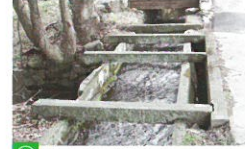
19 吹上の石樋 雄川から引き入れた水は、石材を組み合わせた長さ77mの石樋を通り、雄川堰へと流れていきます。(町指定重要文化財)(D3/拡大下部中央)
