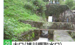
20 大口(雄川堰取水口) 雄川の水を雄川堰に取り込める取水口です。陣屋内の土地と河川との高低差から、大手門から約2.3km上流に取水口が設けられました。(D3)
